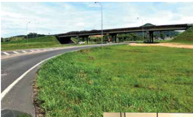
A SC-443 fica no trecho compreendido entre o entroncamento com a Rodovia BR-101 (km 0,0), até o início do Contorno Rodoviário do município de Sangão (km 2,5).
